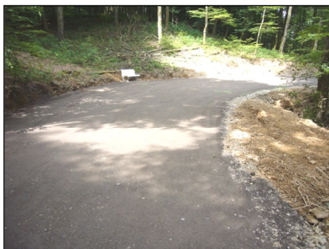
Abbildung 3: Bau neuer Waldwege
